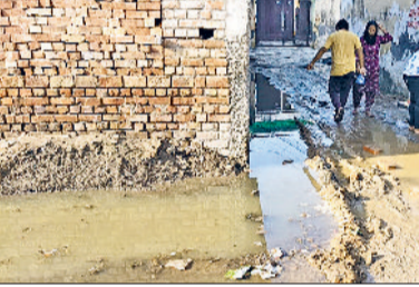
खरखोड़ा। निर्माणाधीन नाले के कारण कीचड़ से गुजरते राहगीर।
